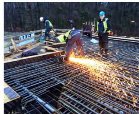
Plaatsen van de omhullingsbuizen in de constructie
