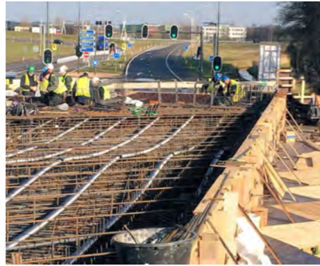
Plaatsen van de omhullingsbuizen in de constructie
