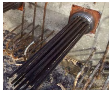
Wigblokken geplaatst
